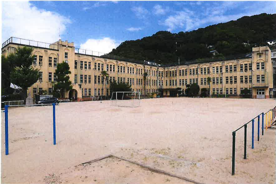
尾道市立久保小学校校舎外観（水田丞撮影）
