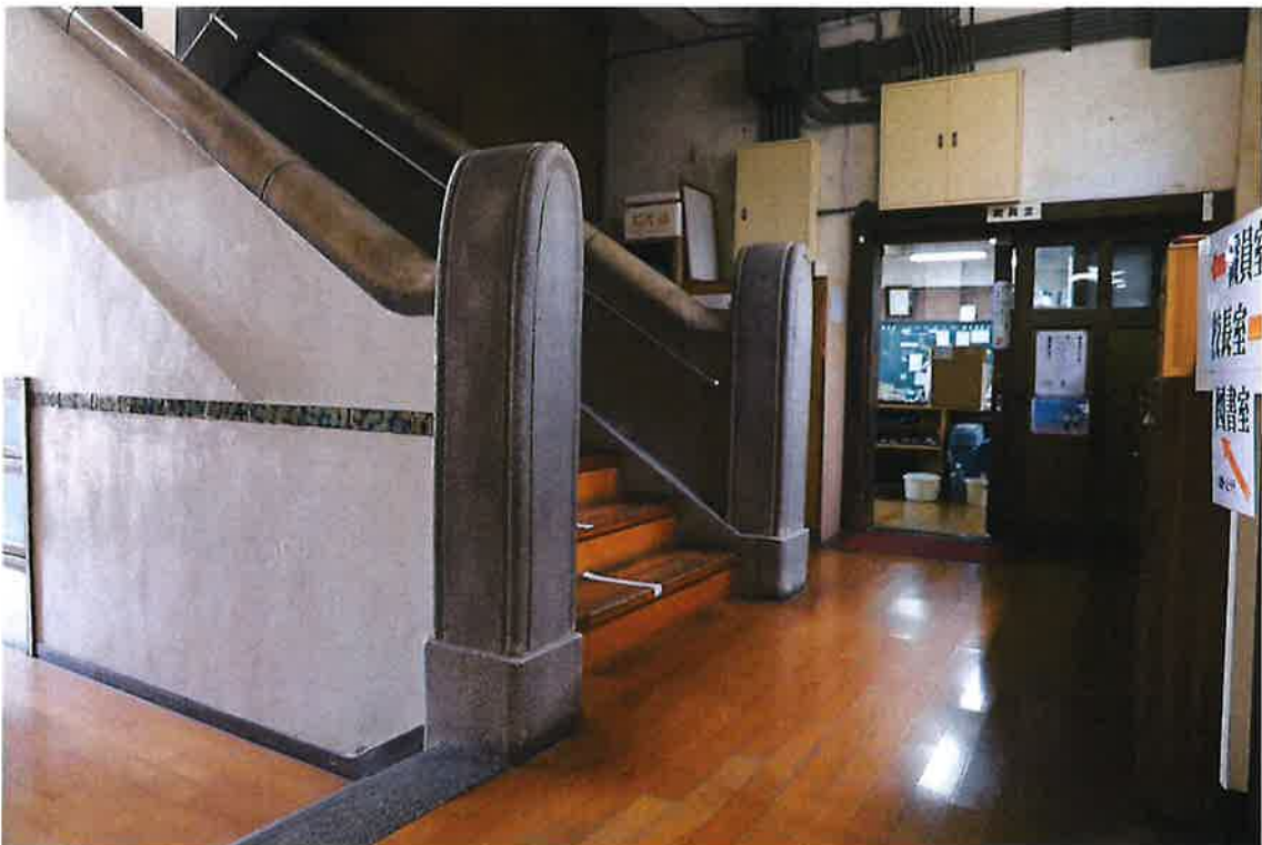
尾道市立久保小学校内部階段親柱（水田丞撮影）
